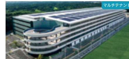
プロロジスパーク八千代1 (千葉県八千代市) 2022年9月竣工
