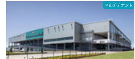
プロロジスパーク古河4 (茨城県古河市) 2023年5月竣工
