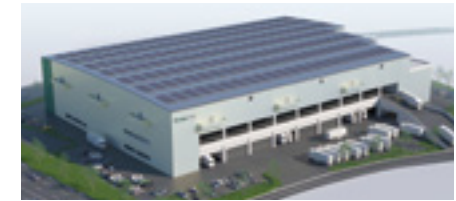
プロロジスパーク仙台東3 (宮城県仙台市)
