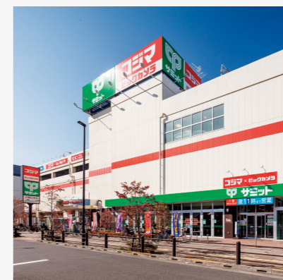
所在地/東京都西東京市 延床面積/10,659.55㎡
