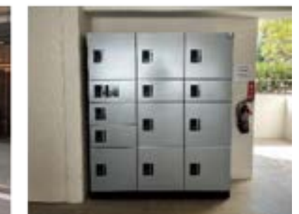
宅配BOX設置 (アルティザ東別院他)
