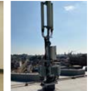
携帯電話等基地局設置 (アルティザ川崎EAST)
