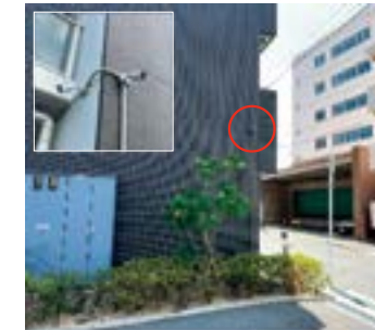
監視カメラ設置 (アルティザ淡路駅東他)
