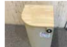
EV内 防災設備の設置 (池下E Sビル)
