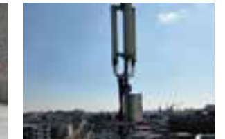
携帯電話等基地局設置 (アルティザ川崎E A S T)
