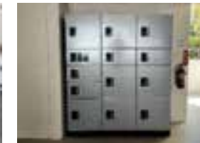
宅配BOX設置 (アルティザ東別院他)
