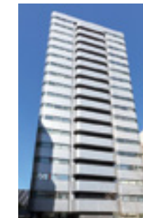
⑮ 横浜STビル
