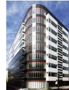
Office 大宮宮町ビル 所在地:埼玉県さいたま市
