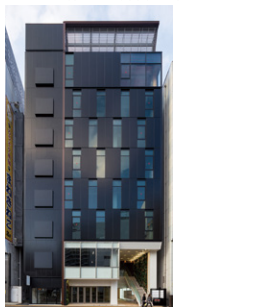
Retail 仙台南町通ビル 所在地:宮城県仙台市
