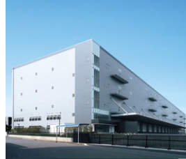
Logistics 市川ロジスティクスセンター 所在地:千葉県市川市
