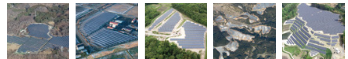
S-21 CS伊豆市発電所 S-22 CS石狩新篠津村発電所 S-23 CS大崎市化女沼発電所 S-24 CS日出町第二発電所 S-25 CS大河原町発電所
