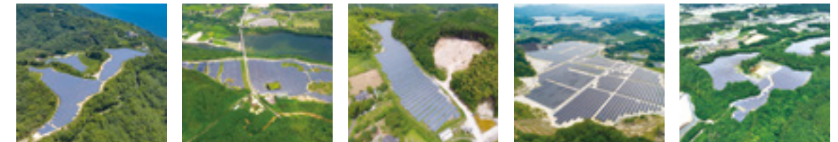
S-26 CS福山市発電所 S-27 CS七ヶ宿町発電所 S-28 CS嘉麻市発電所 S-29 CSみやこ町犀川発電所 S-30 CS笠間市第三発電所
