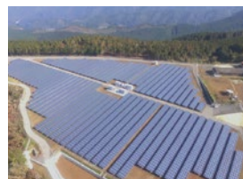
S-09 CS芦北町発電所
