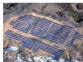
S-11 CS皆野町発電所
