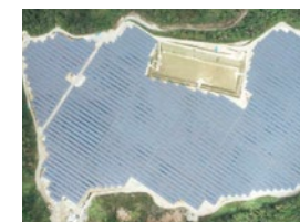
S-33 CS広島市鈴張発電所
