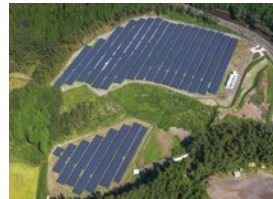
S-05 CS湧水町発電所
