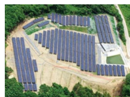
S-19 CS美里町発電所
