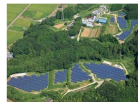
S-12 CS函南町発電所
