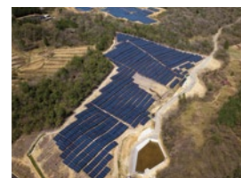
S-16 CS恵那市発電所
