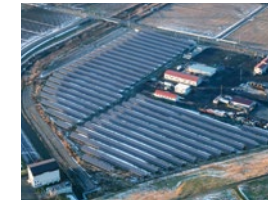
S-22 CS石狩新篠津村発電所
