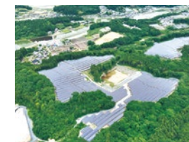
S-30 CS笠間市第三発電所
