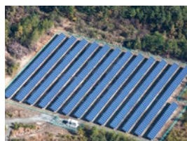
S-14 CS郡山市発電所
