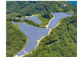
S-26 CS福山市発電所
