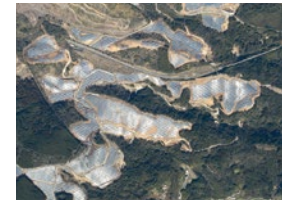
S-24 CS日出町第二発電所
