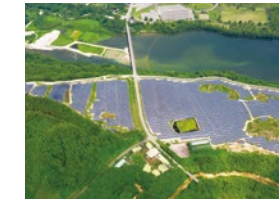
S-27 CS七ヶ宿町発電所
