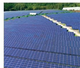
S-05 鉾田太陽光発電所
