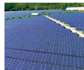
S-05 鉾田太陽光発電所
