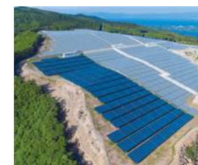
S-06 長崎琴海太陽光発電所
